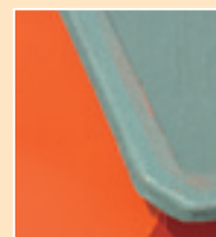
Revestimiento en fibra de vidrio.
